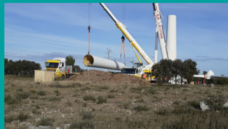
Photo : démantèlement du premier parc éolien français à Port-la-Nouvelle en 2019. 96% des composants ont été recyclés.
